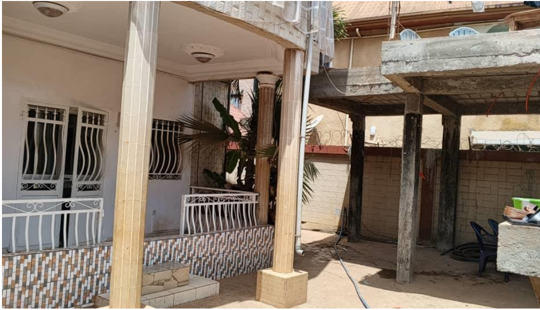
Figure N° 3 : un habitat en dur à Kobaya protégé contre les inondations
