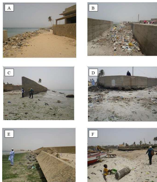
Photo 2 : Photographie (A) vue de la partie terminale de la digue en enrochements à Diokoul ; (B) remplissage de l'espace entre le mur mixte et le nouveau mur béton de Diokoul par des ordures ménagées ; (C) nouveau mur en béton de Diokoul implanté devant le mur mixte plus ou moins effondré ; (D) mur mixte en gabion surmonté d'un mur en béton. La base du mur est affouillée ; (E) mur mixte du cimetière musulman de Diokoul, son extrémité est effondrée ; (F) le haut de plage de la zone de débarquement avec une vue en arrière-plan d'un ouvrage hydraulique. (Source, modifié par M ; Diallo, EGIS, 2013)
