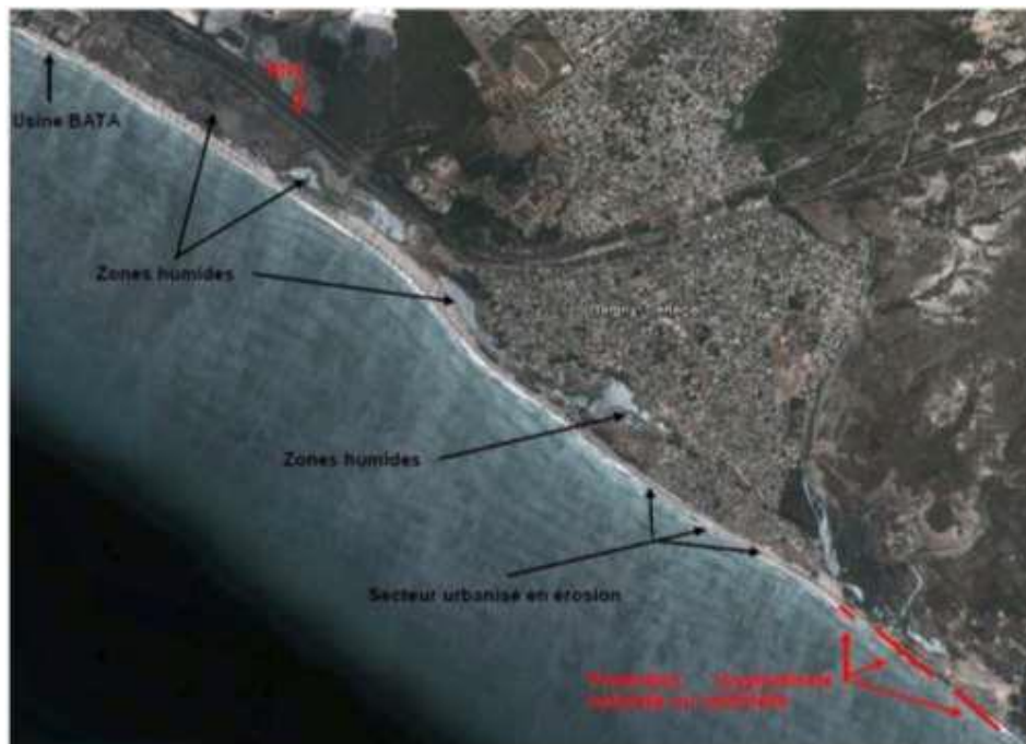
Figure 16 : Localisation des ouvrages de protection le long du littoral sur l'axe Bargny-Sendou (source Egis, 2013)
