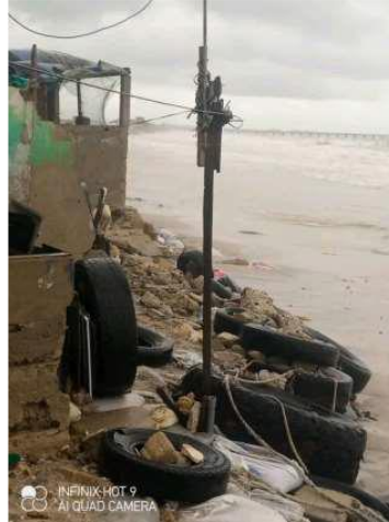
Photo 4 : La protection contre l'avancée de la mer par la mise en place des roches et pneus devant les habitats à Bargny (image fournie par association CRAC, 2022)
